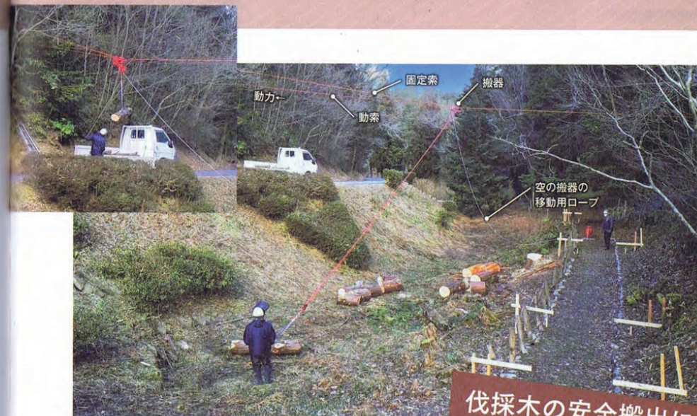
搬器と繊維ロープによるシンプル架線で危険木を運び出しているところ
